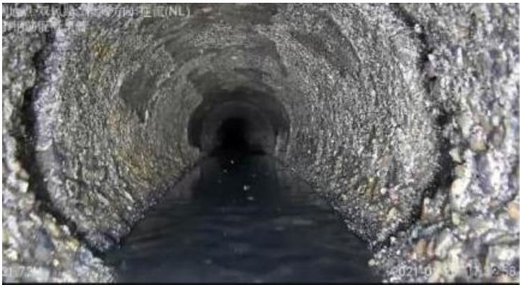
管道腐蚀
