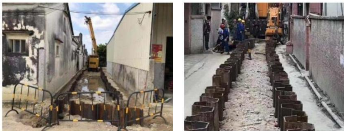
图5.1-3静压钢板桩施工案例
