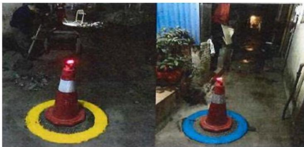
图5.1-1雨水标识刷涂示意图
