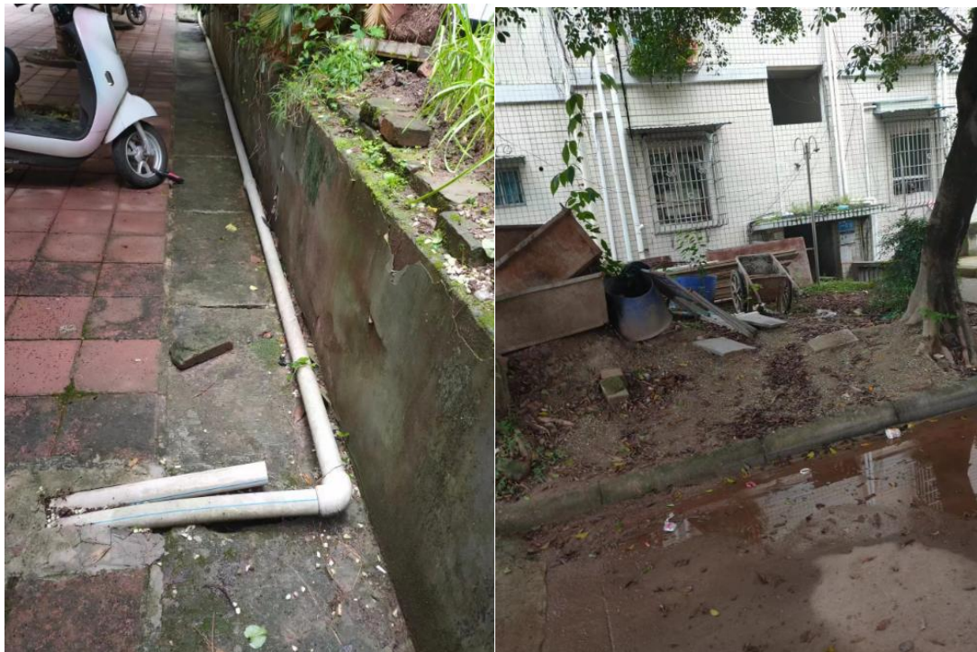
室外排水破损老旧出现内涝
