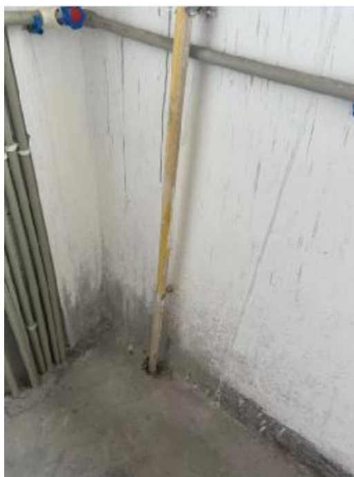
图 2.1.4-2 内江市居民楼内立管锈蚀现状图
